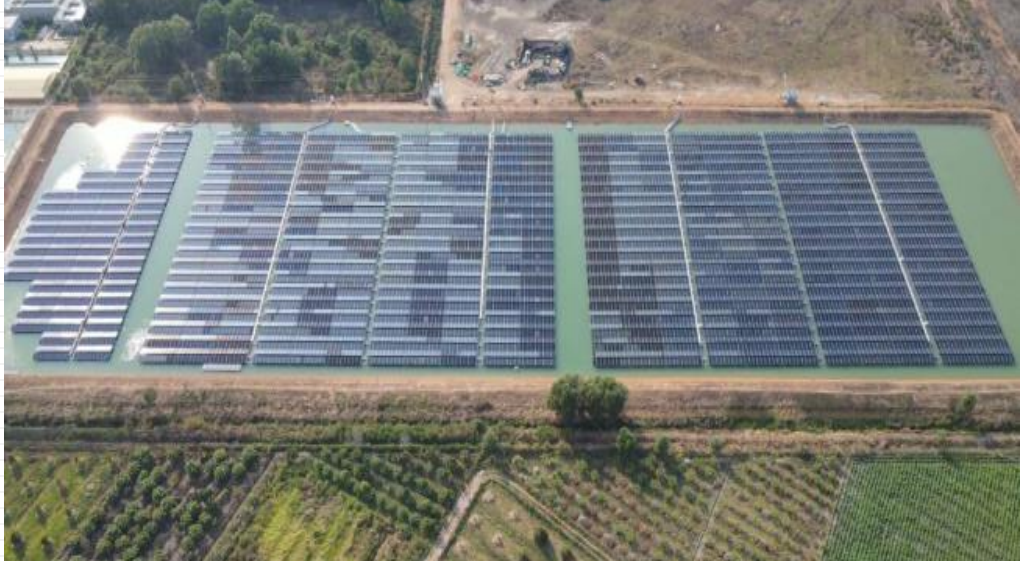
2023 г., Вьетнам, Фуок Донг, плавающая ФЭС, 4 МВт
