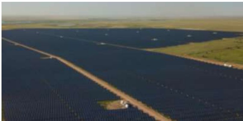
На фото: СЭС в г.Сарань 100 МВт (финансирована ЕБРР и ЗКФ)
