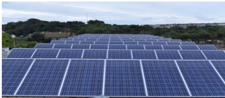
Средняя школа № 235 (25К кВт электроэнергии, 40 кВт отопление)
