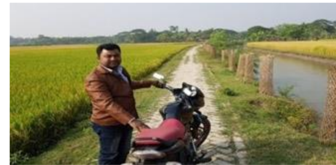
Дорога, проложенная путем выкапывания дренажного канала
