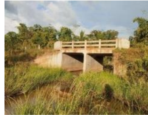
Использование водопропускных труб соответствующего размера
