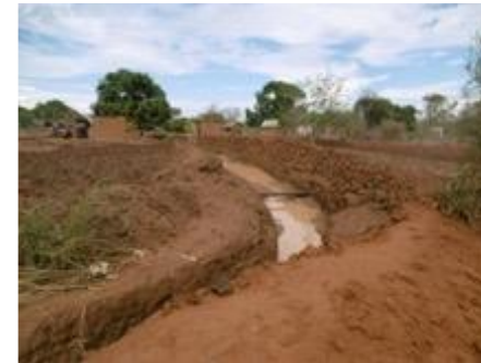
Полевая траншея от дороги
