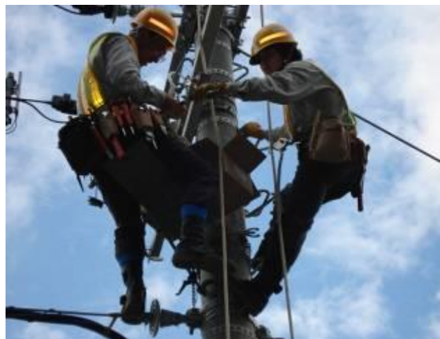
■ Монтаж распр. линии
