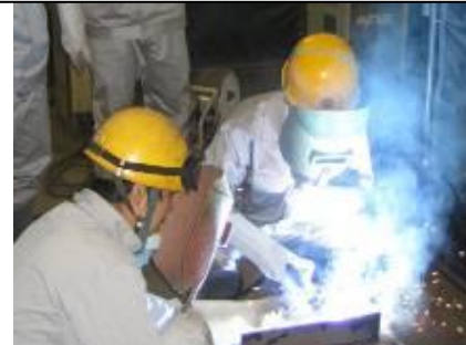
Разработка стального моста (строительство)
