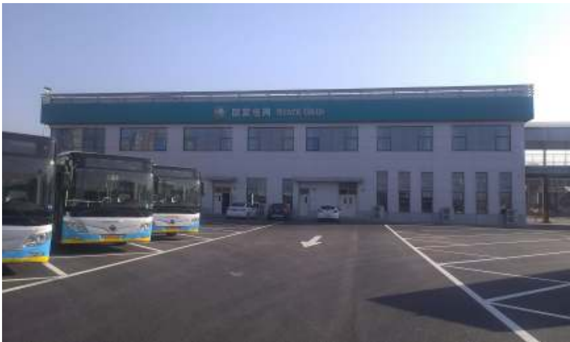
图：四惠电动汽车充换电站
