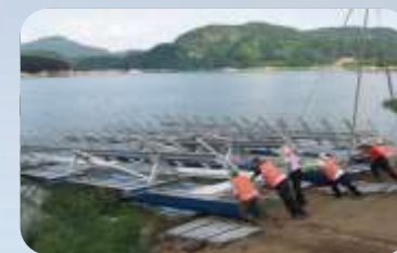
Строительство на сухопутном участке
