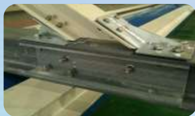
Прокаливаемая сталь + обычное болтовое крепление
